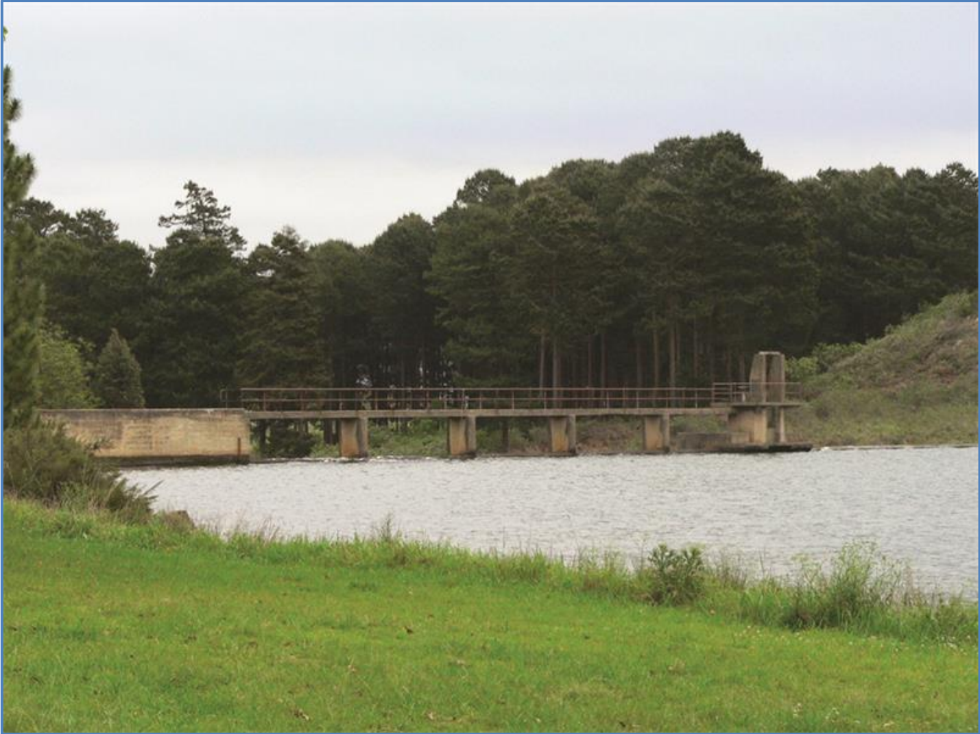
Figure 17.6 Grootgewacht Dam (DWA, 2015)
