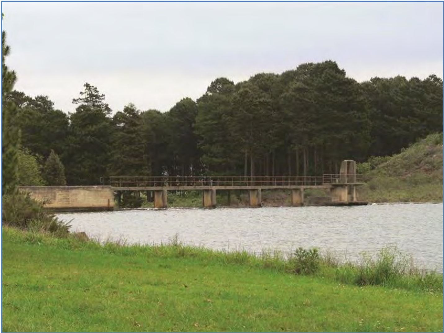
Figure 17.6 Grootgewacht Dam (DWA, 2015)
